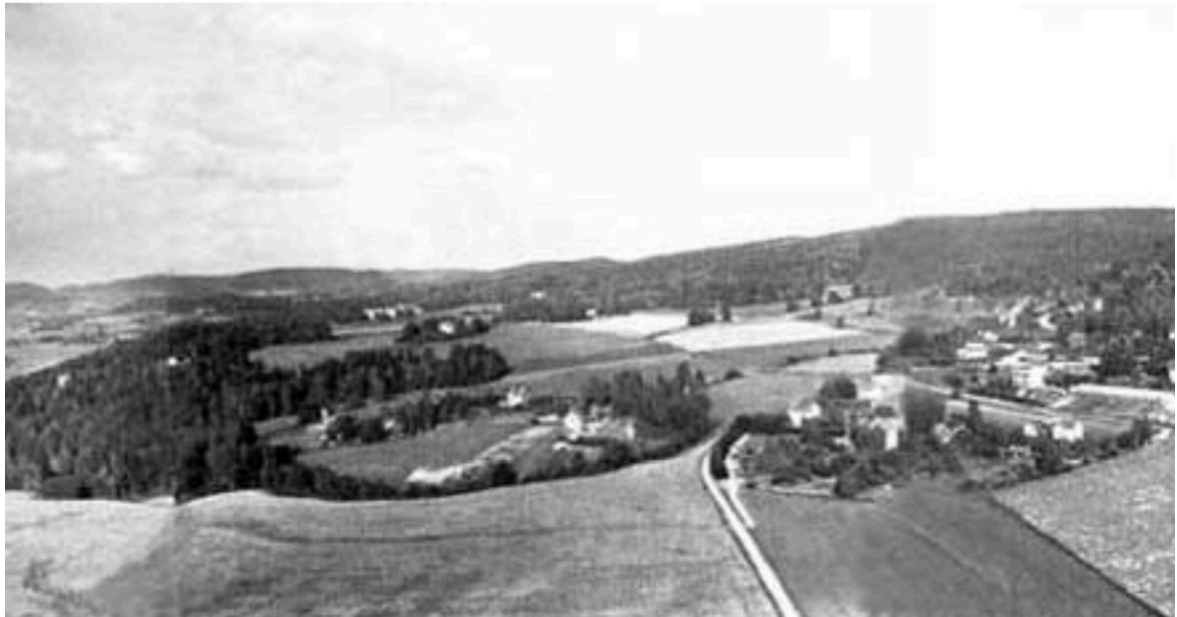
Bilde: Han klatret til topps i masten på 60 meter. Fra en av radiomastene på Hellerud etter freden 1945. Utsyn mot Haugerud og Trosterud. Henrik Dedichen©.
